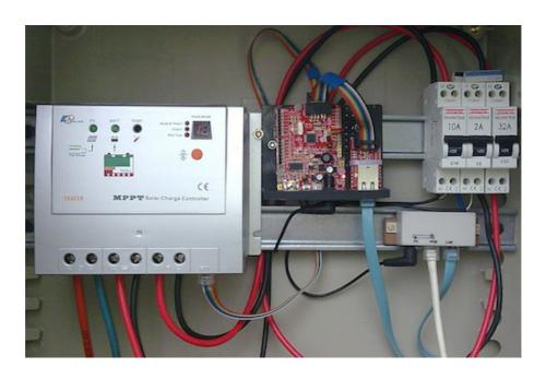
Montage Arduino de contrôle et de commande de station solaire en site isolé
